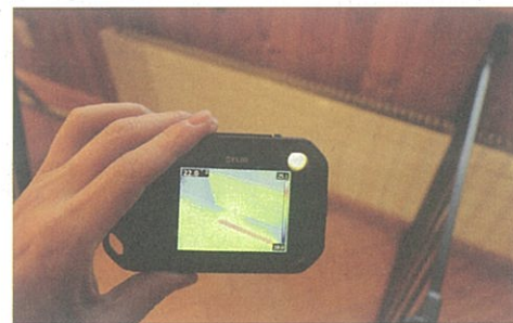
コンフォート24による暖房温度。窓下のパネルヒーターは停止しており、手前の床グリルから暖気が上がっていることがサーモカメラ画像からわかる
