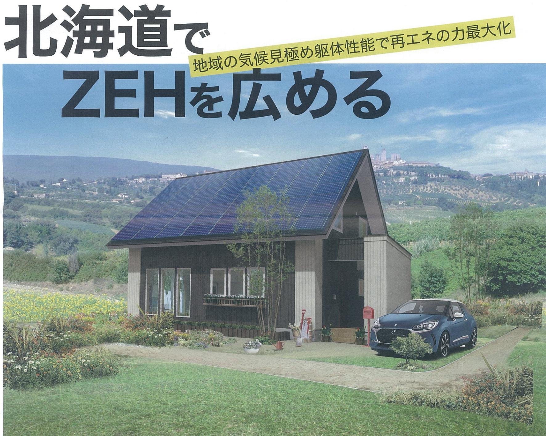
ハウス・オブ・ザ・イヤー・イン・エナジー 2021で大賞を受賞した「eco-house ZeRo (エコハウスゼロ)」。現実的な太陽光発電の搭載量5～6kWでゼロエネを目指した
