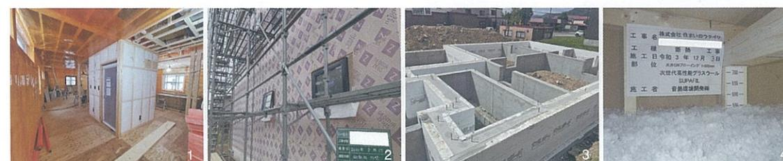
1・外壁は吹き込み専用のグラスウール充填と、フェノールフォームの付加断熱という構成。
