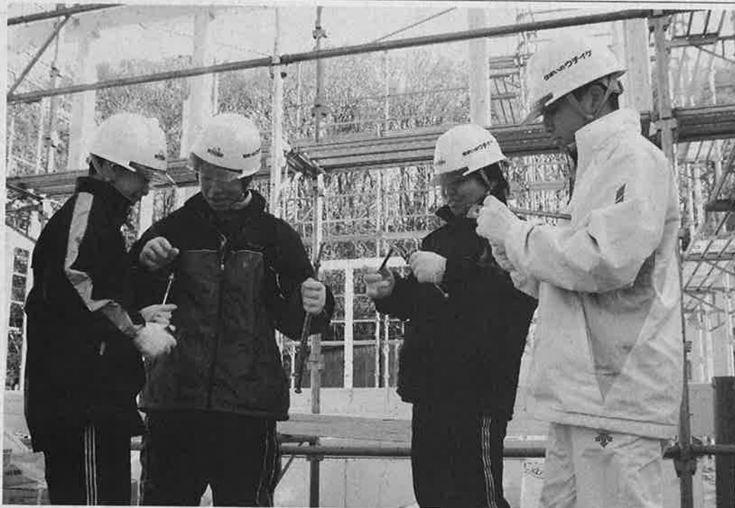
建設工事現場で金具の組み立作業に励む本室蘭中の生徒たち
