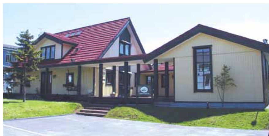
ソーラーパネルを設置した室蘭モデルハウス
